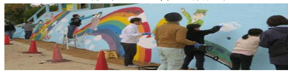
11/30 とうちゃんず：運動場東壁面の修復作業 H20年度卒業制作の修復作業を行いました
